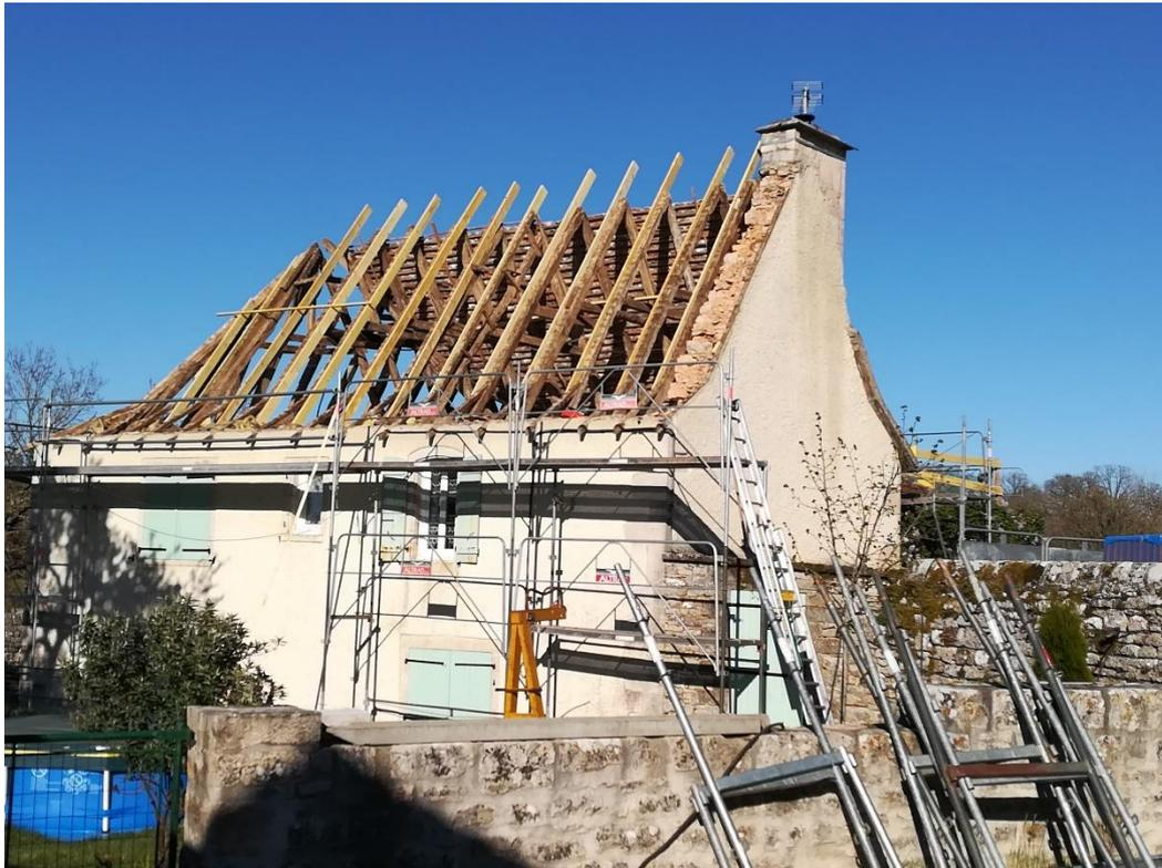
En plus de ces travaux, les intempéries ayant encore frappé, la toiture haute du presbytère a dû être changée intégralement par suite d'infiltrations d'eau dans les pièces de l'étage.
